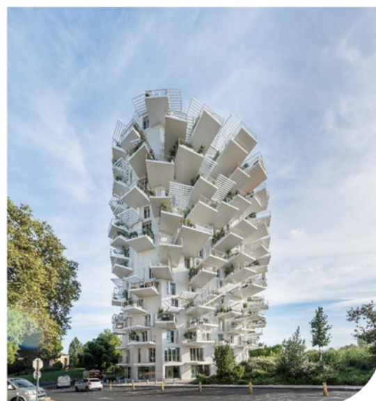
L'Arbre Blanc, Montpellier, France SOU FUJIMOTO ARCHITECTS, OXO Architectes, DREAM, Nicolas Laisné Architectes
